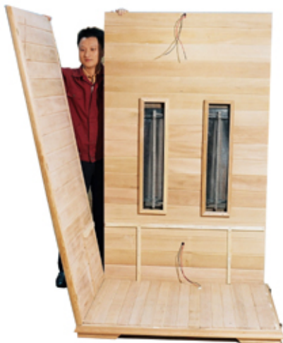
FIG-5 Montage der linken Seitenwand
